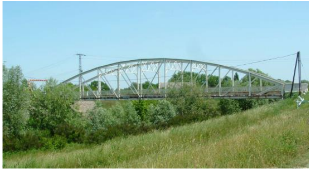
Kiskörei Tisza-híd (fotó: https://www.mavcsoport.hu/mav-csoport/megujult-kiskorei-tisza-hid )
